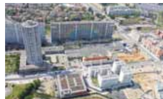
Các chung cư cực lớn ở khu Duchère, Lyon, đầu năm 2010
