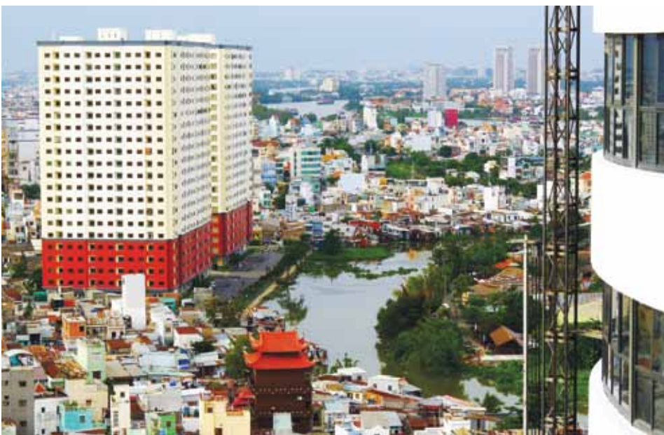
◀ Nhà ở đa dạng tại quận Bình Thạnh, TP.HCM: nhà tạm bợ trên kênh, nhà liên kế, chung cư hạng thường và chung cư cao cấp
