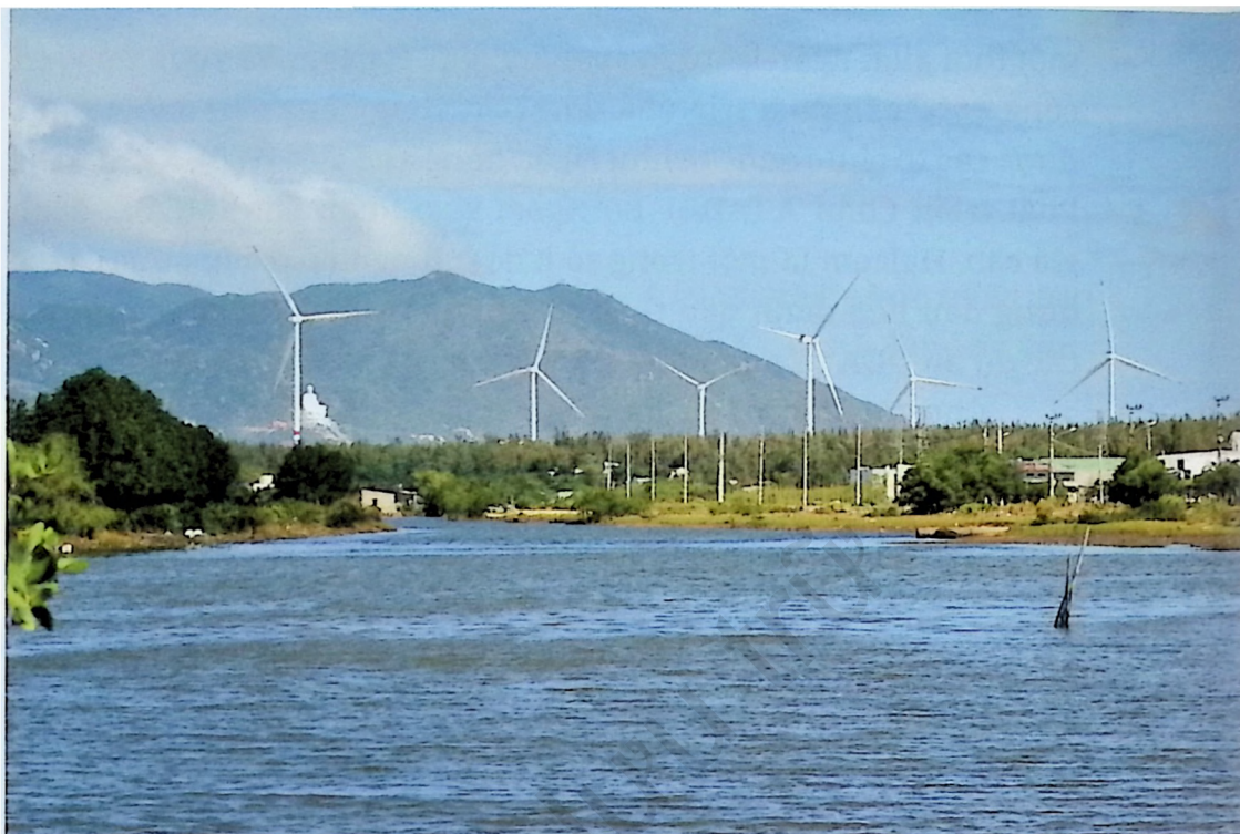
Nhà máy Phong Điện Phương Mai 3 (Bình Định) do Halcom Việt Nam làm chủ đầu tư, vận hành thương mại vào tháng 1/2020.
