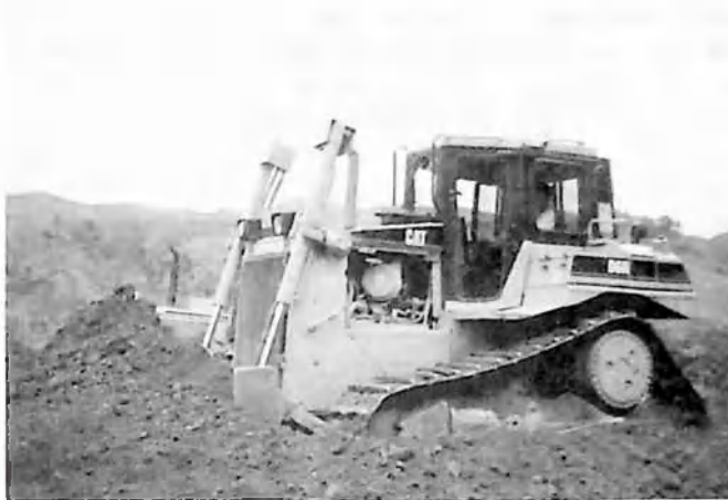
Mở đường quốc lộ đoạn Si Pha Phìn - Mường Nhé
