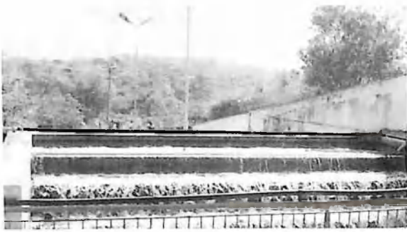
Một góc trạm lọc nước của Công ty Quản lý Cấp nước
