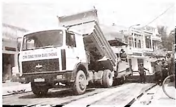
Nhân viên Công ty Công trình Giao thông Lai Châu đang thi công tuyến đường nội thị
