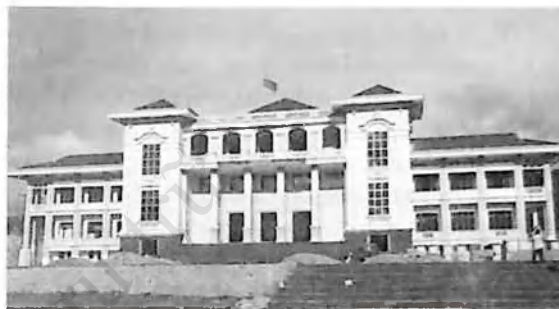
Trung tâm Hội nghị tỉnh Lai Châu - Công trình do Công ty Xây dựng số 11 thi công được đánh giá cao về kỹ thuật và thẩm mỹ
