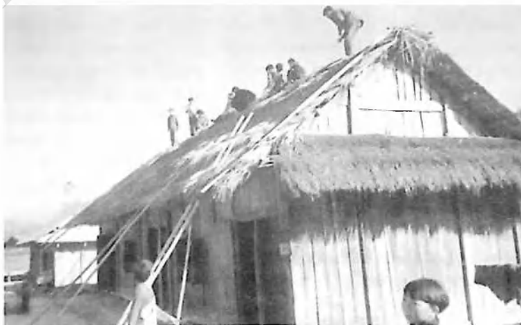
Đội công tác xây dựng cơ sở Si Pa Phìn huyện Mường Lay giúp dân sửa chữa trường học
