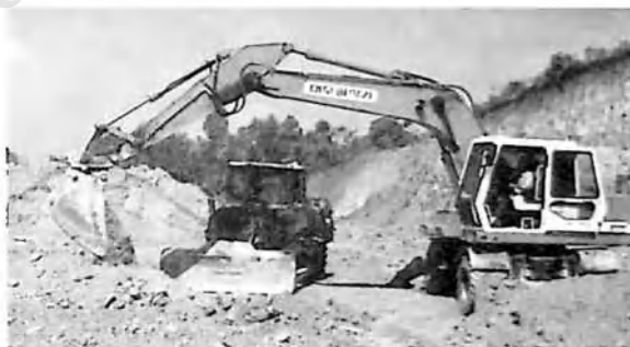
Construction of ground levelling in Pu Tieu, Dien Bien district
