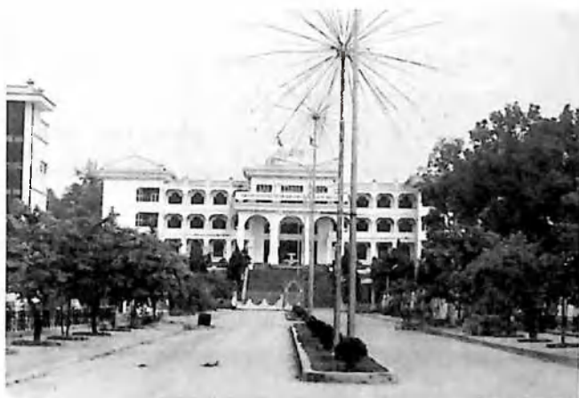
Trụ sở Tỉnh ủy Lai Châu do Công ty Xây dựng số 2 Lai Châu thi công
